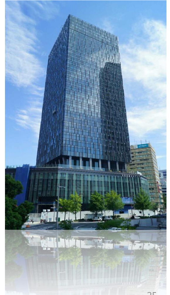
大名古屋ビルヂング
