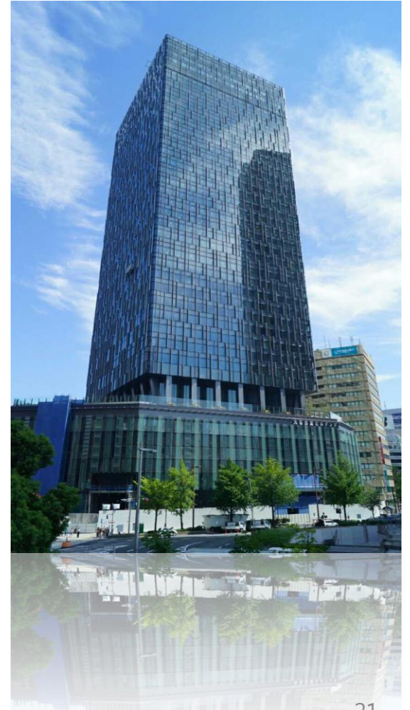
大名古屋ビルヂング
